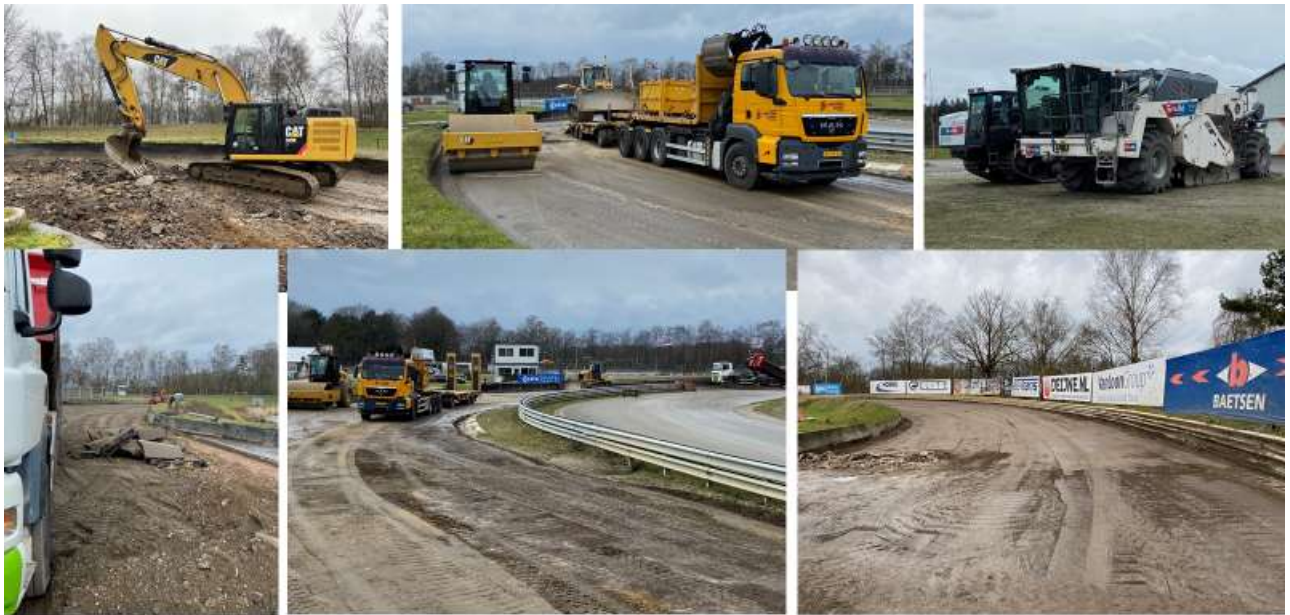
Impressie van het groot onderhoud aan het onverharde deel. Met vakmanschap en groot materieel wordt de klus geklaard.
